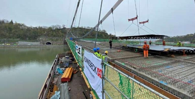
Abfahrten machten Ausbrüche in Dimensionen notwendig, die nur im Mühlviertler Granit möglich sind. Auch die Verankerung der zahlreichen, je 65 Tonnen schweren Tragseile ist nur bei uns möglich. Derzeit wird gerade die Stahlbrückenkonstruktion mit Fertigbetonelementen gedeckt. Diese müssen dann noch überbetoniert werden. Die Auf- und Abfahrten mit ihren Portalen sind schon größtenteils fertig gestellt. Nun folgt die technische
