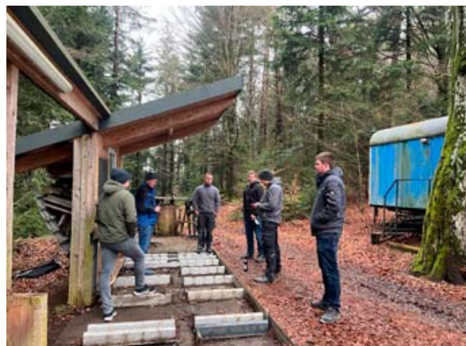
Renovierung der Kegelbahn
