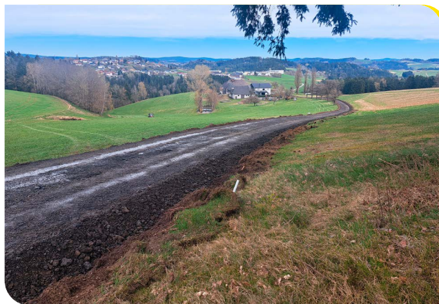
Straßenbauprojekte sind bereits im vollen Gange
