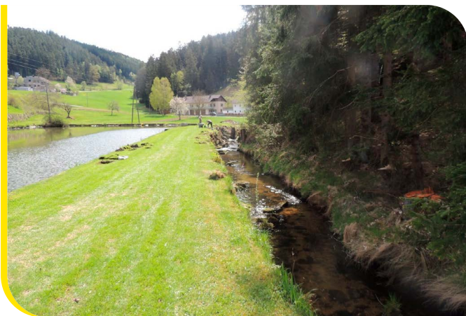
Notwendige aber aufwändige Arbeiten am Damm
