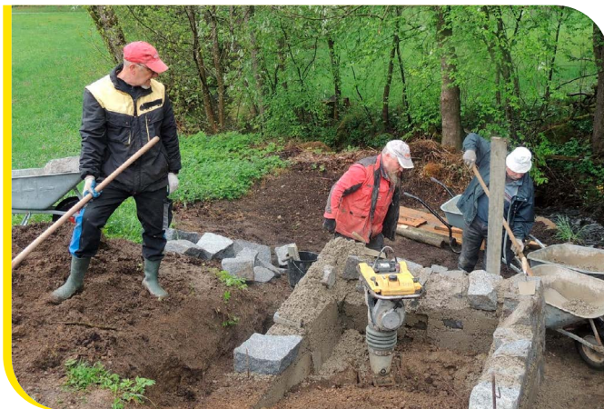
Auch die Kompoststelle wurde ausgebessert
