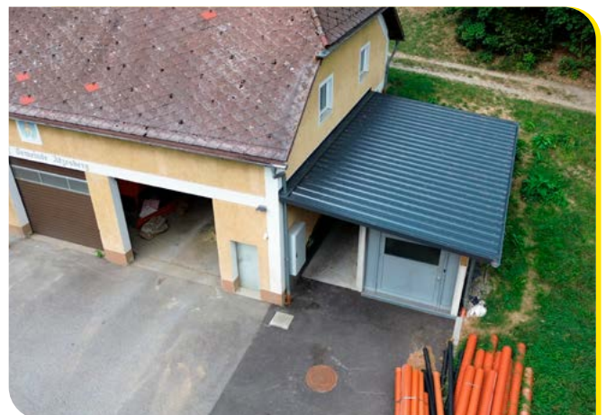
Die fertiggestellte Wildkammer
